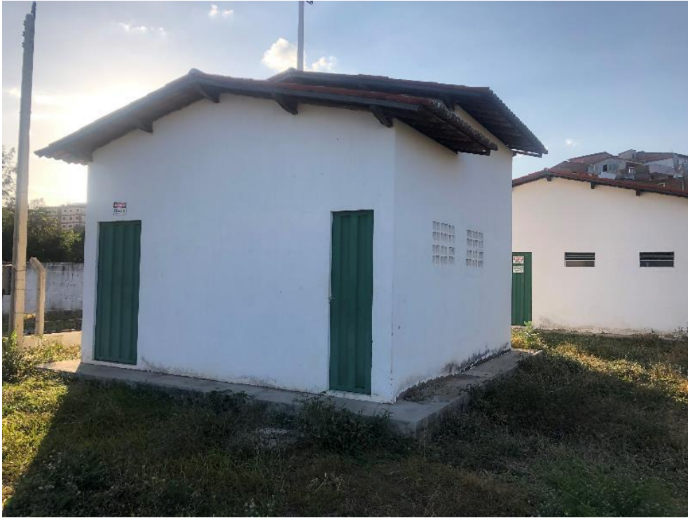
FIGURA 54. VISTA GERAL DA CASA DO GERADOR.
