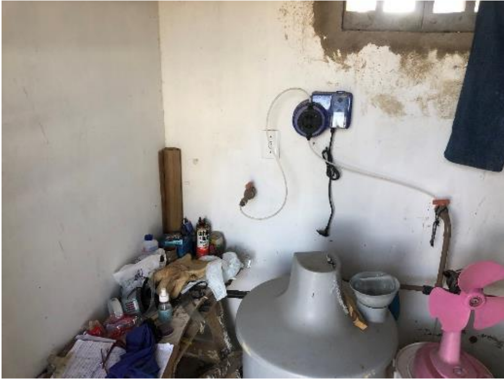
FIGURA 38. CASA DE QUÍMICOS.
