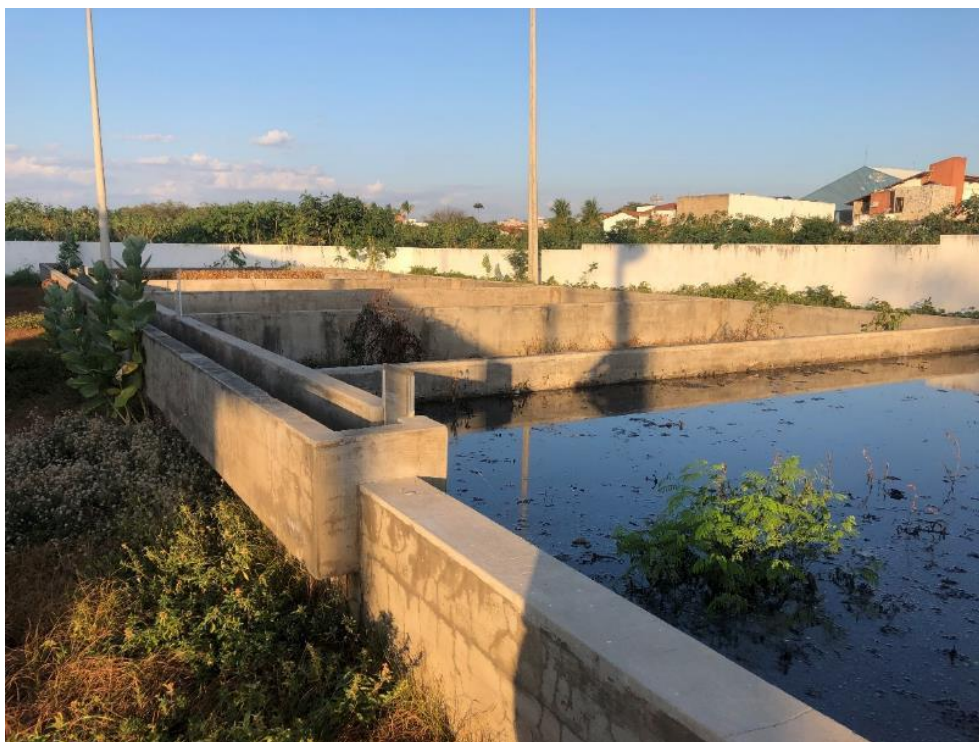
FIGURA 60. LEITOS DE SECAGEM.
