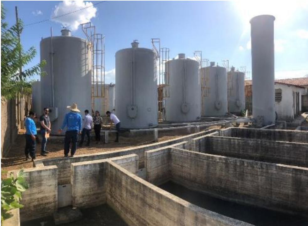
FIGURA 31. VISTA GERAL DA TORRE DE CARGA E REATORES ANAERÓBIOS.
