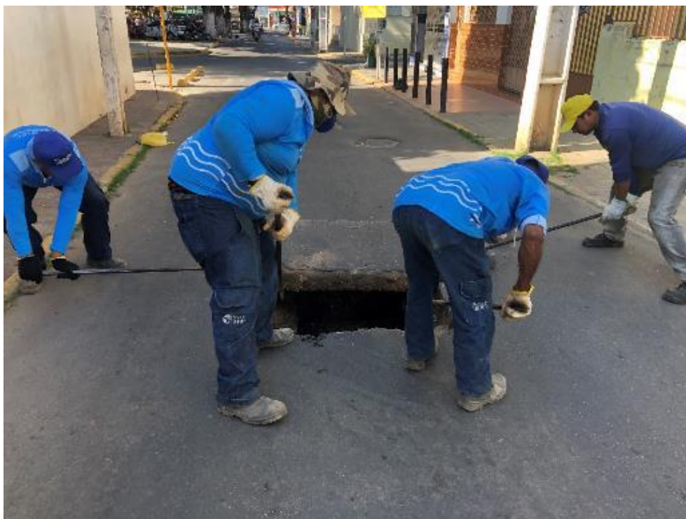
FIGURA 23. DESOBSTRUÇÃO DE REDE COLETORA.
