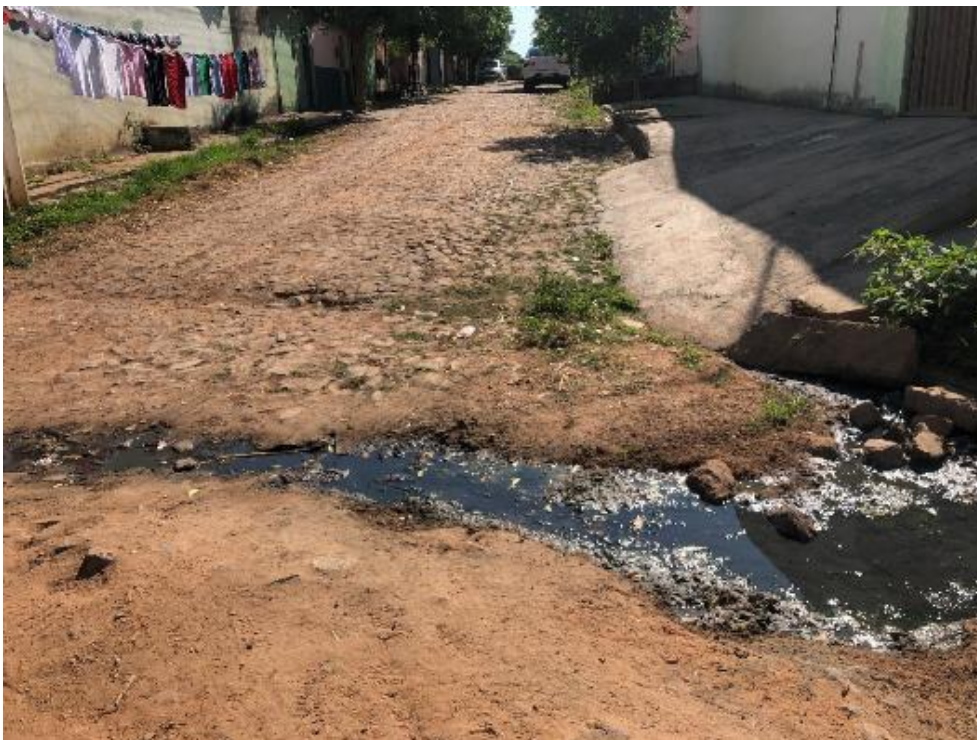
FIGURA 15. PC-05 - LANÇAMENTO DE ESGOTO A CÉU ABERTO.
