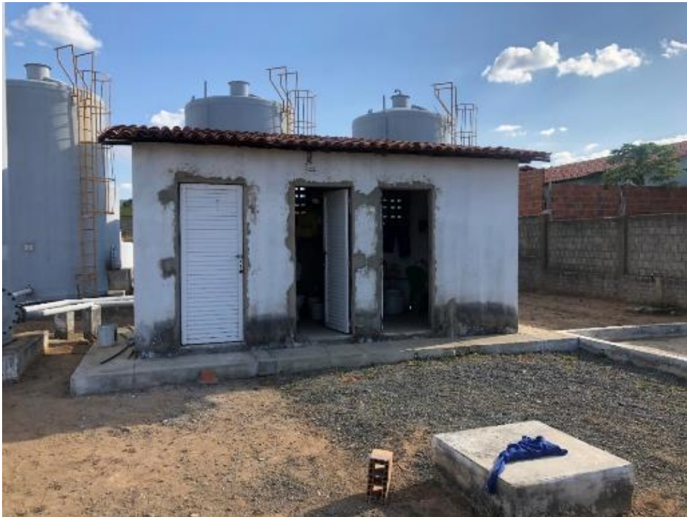
FIGURA 37. CASA DE ALMOXARIFADO, BANHEIRO, PAINÉIS E QUÍMICOS.
