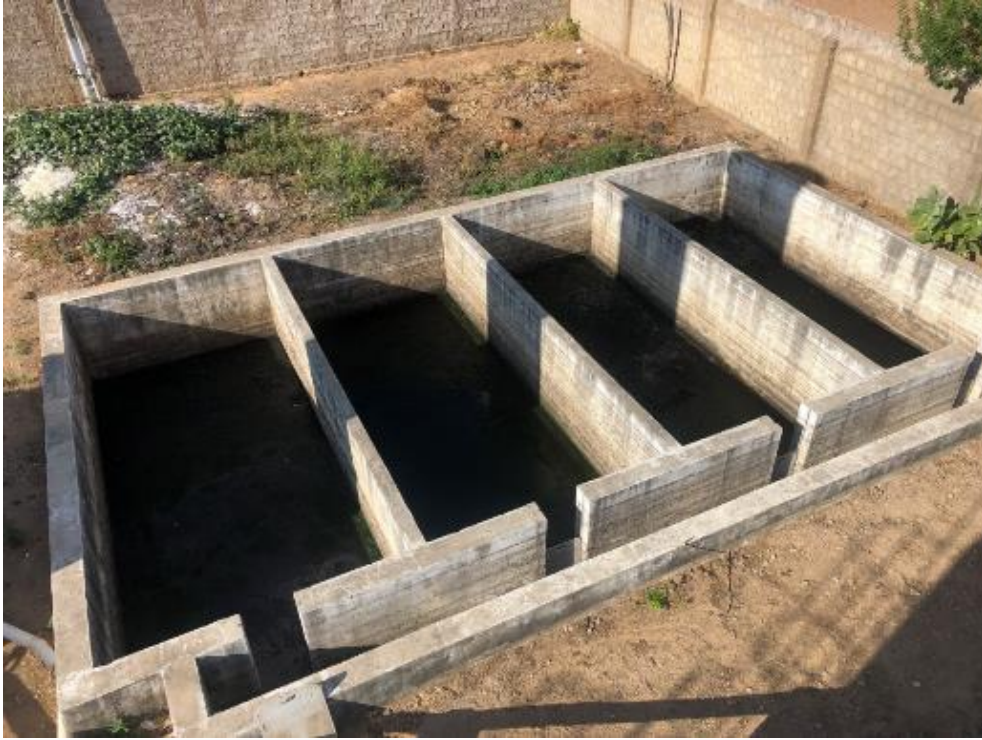
FIGURA 36. LEITOS DE SECAGEM.
