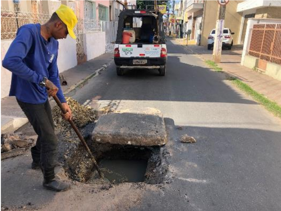
FIGURA 19. PC-07 – DESOBSTRUÇÃO DE REDE COLETORA.
