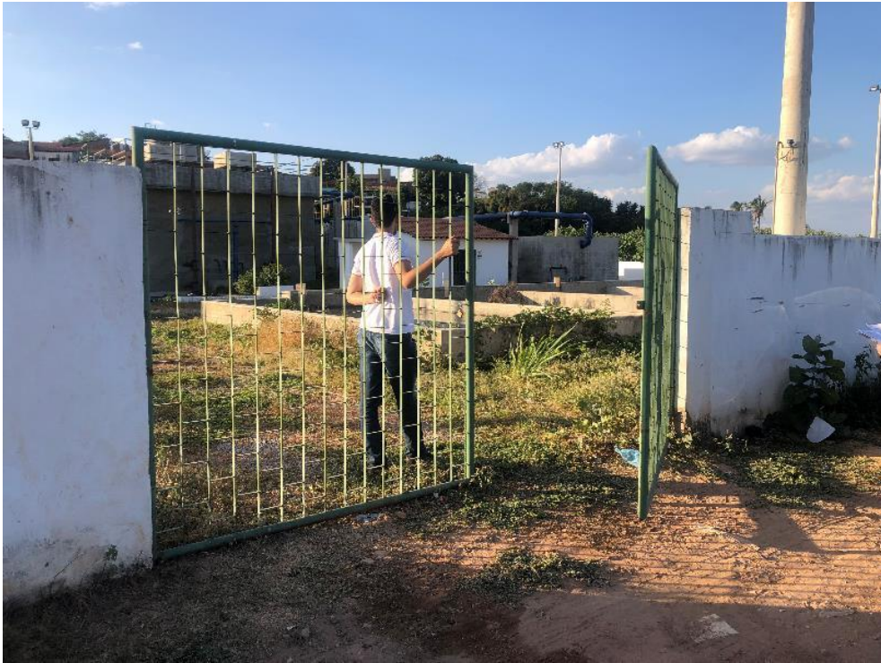
FIGURA 42. VISTA GERAL DO ACESSO A ETE.
